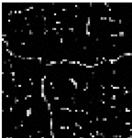
利用裂缝特征提取 裂缝种子点
